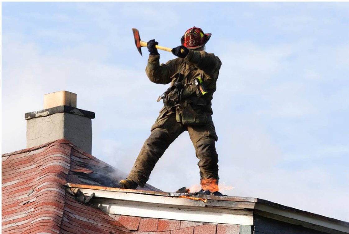
Brandbekämpfung auf dem Dach; Foto Solaredge
