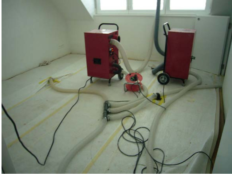
Abbildung 07: Unterdrucktrocknung nach einem Wasserschaden
