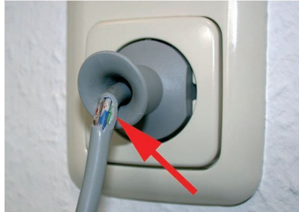
Beschädigte Geräte-Anschlussleitung
